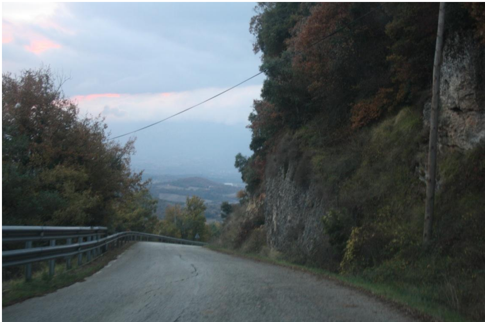
Macizo rocoso agrietado, con peligro de desprendimiento sobre la calzada.
