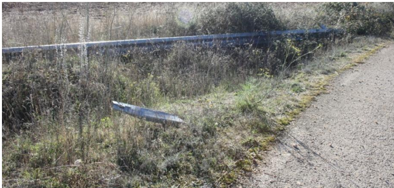
Bionda y sopote deteriorados
